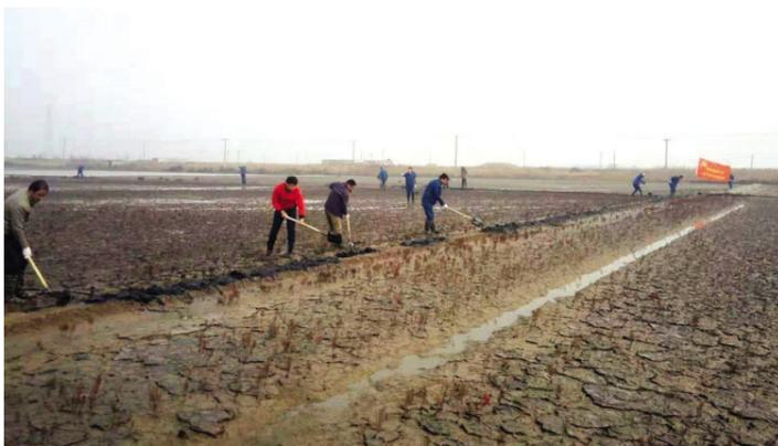
连日来,徐圩投资公司抢抓晴好天气,全面推进“手牵手、互帮助”滩内工程,悦升、台南综合服务中心、养殖资源等单位相继牵手新滩、方洋等四大工区,开展修滩、打卤站、做埝、除草等冬准相关工作。为2019年原盐生产实现4万吨夯实基础。(戴月婷)
